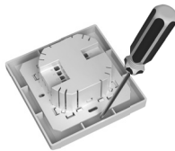
Рис. 7. Демонтаж лицевой панели
