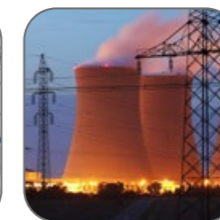
Объекты энергетической отрасли
