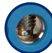
Винт надежно без повреждений закрепляет проводник.
