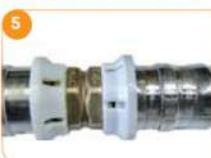
Контроль выполненного прессования – глубина вставки трубы определяется по контрольным отверстиям пресс-кольца, на наружной поверхности пресс-втулки видны два параллельных кольцеобразных углубления, а между ними ровная поверхность.
