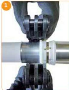
Выбрать хомут в соответствии с размером фитинга и обратить внимание, чтобы поверхности контура манжеты были чистыми и гладкими. При этом маркировочные метки на скользящих сегментах и полусферах хомута должны быть на одной линии, в противном случае хомут считается неисправным. Необходимо обеспечить совпадение меток самостоятельно, либо передать в ремонтную мастерскую. Установить пресс-хомут широким пазом к пластиковому кольцу фитинга. Сегменты пресс-хомута должны плотно прилегать к фитингу.
