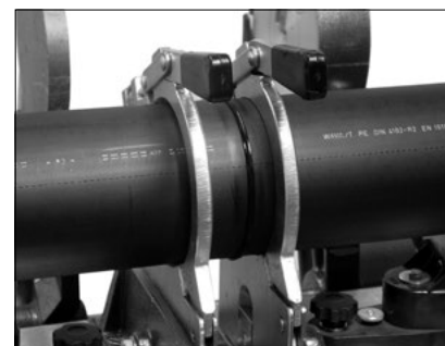
Охлаждение сварного шва
